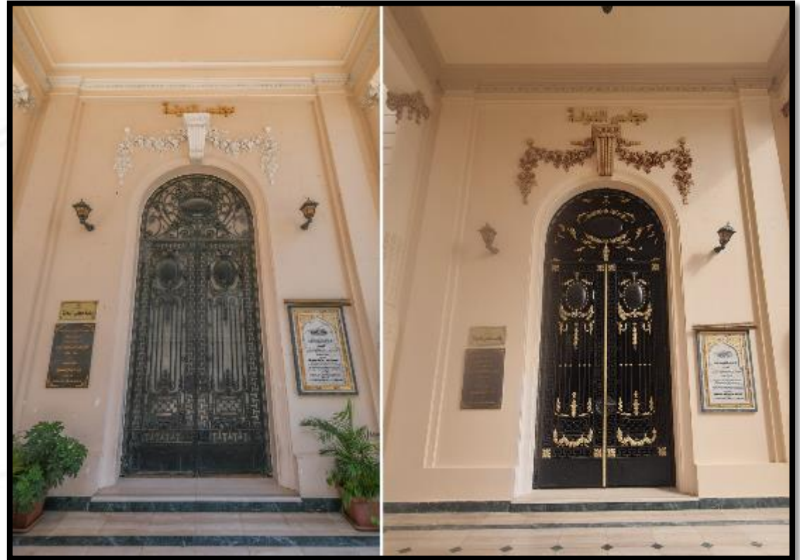
قبل اعمال الترميم
