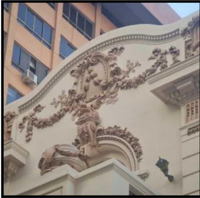
بعد اعمال الترميم
