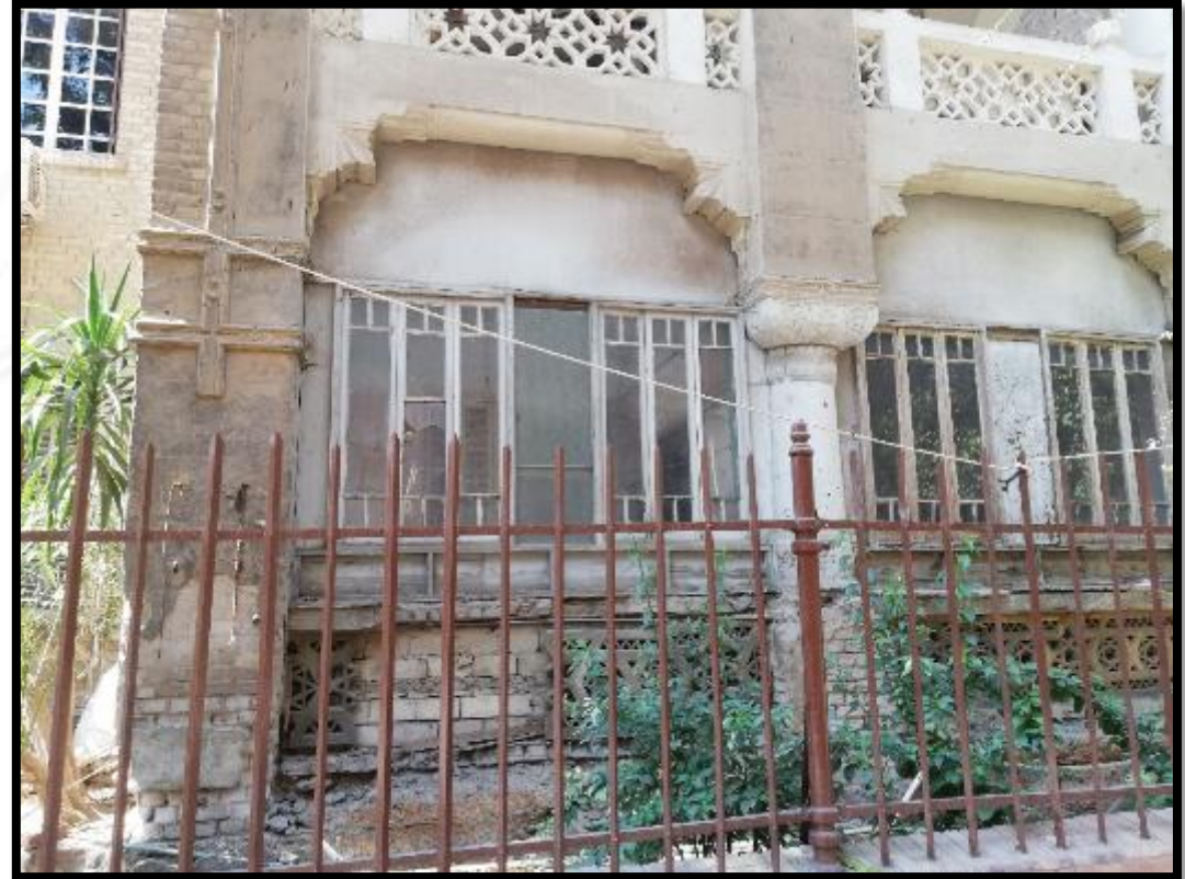
قبل اعمال الترميم
