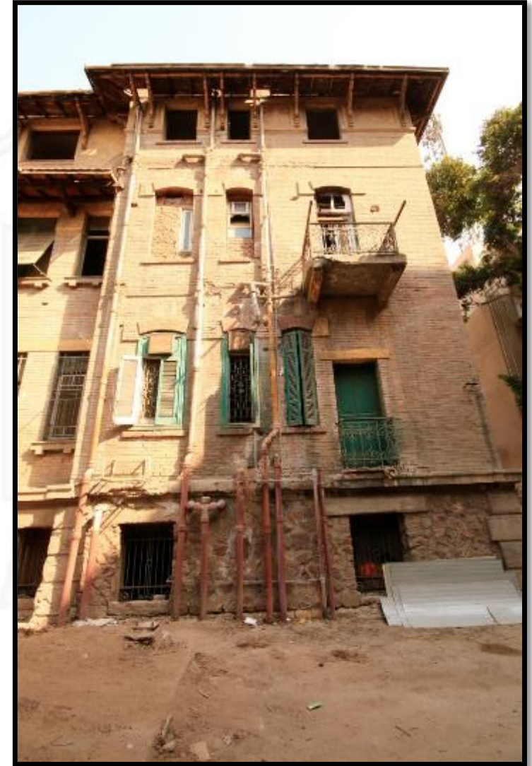
قبل اعمال الترميم
