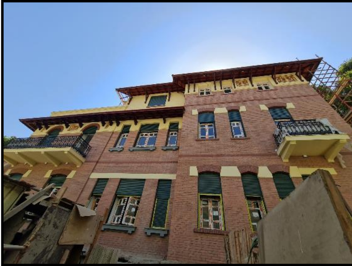
بعد اعمال الترميم
