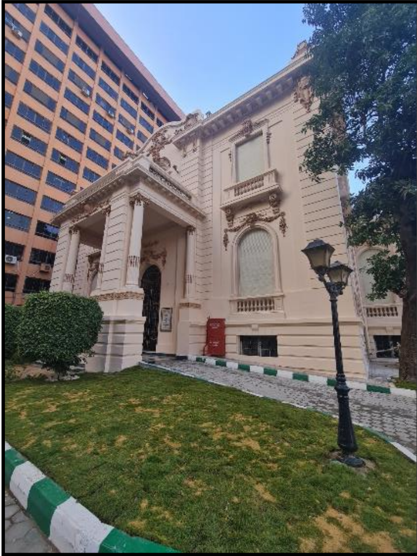
بعد اعمال الترميم
