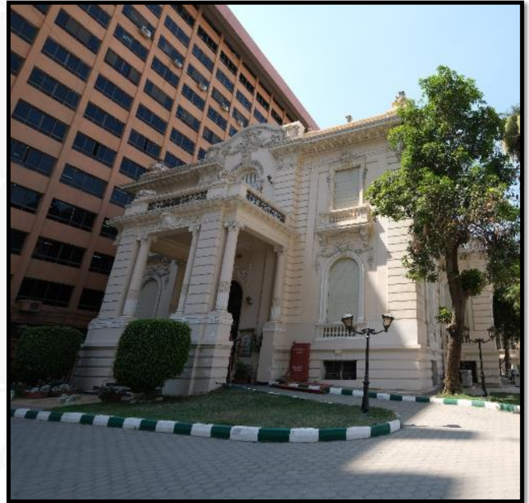
قبل اعمال الترميم
