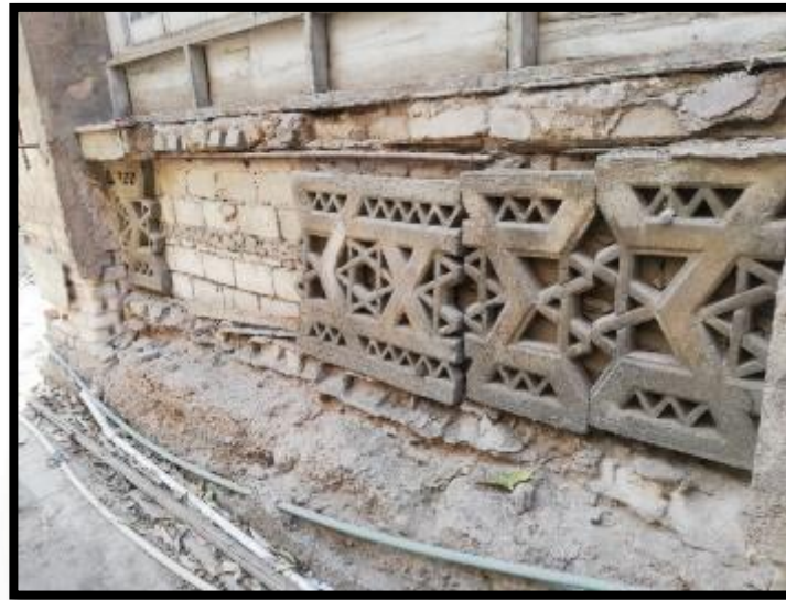
قبل اعمال الترميم
