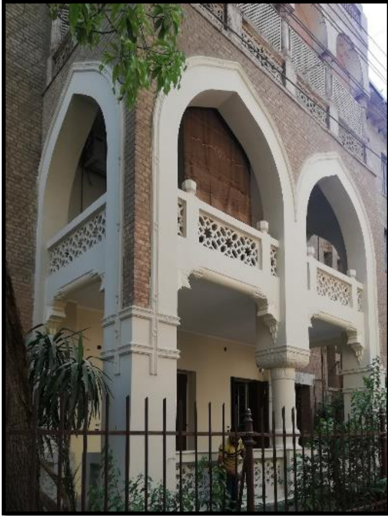
بعد اعمال الترميم
