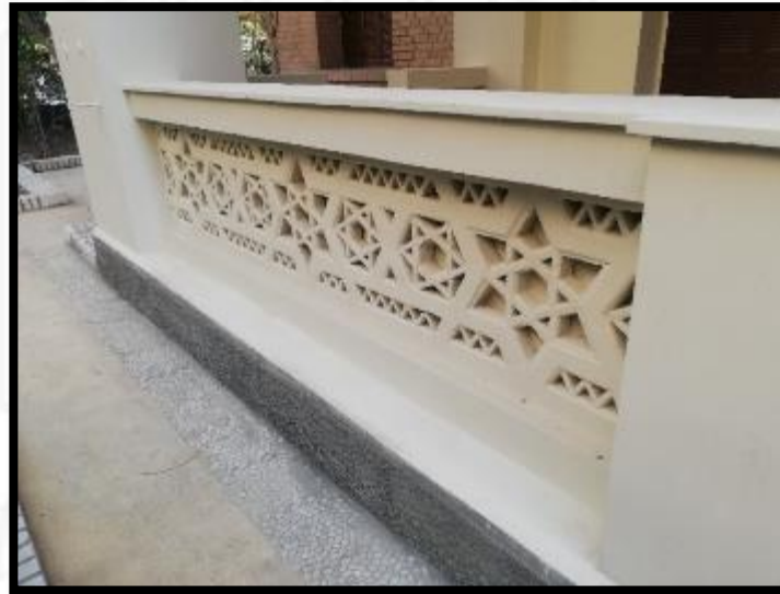
بعد اعمال الترميم
