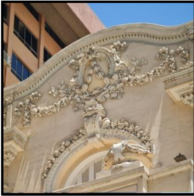
قبل اعمال الترميم
